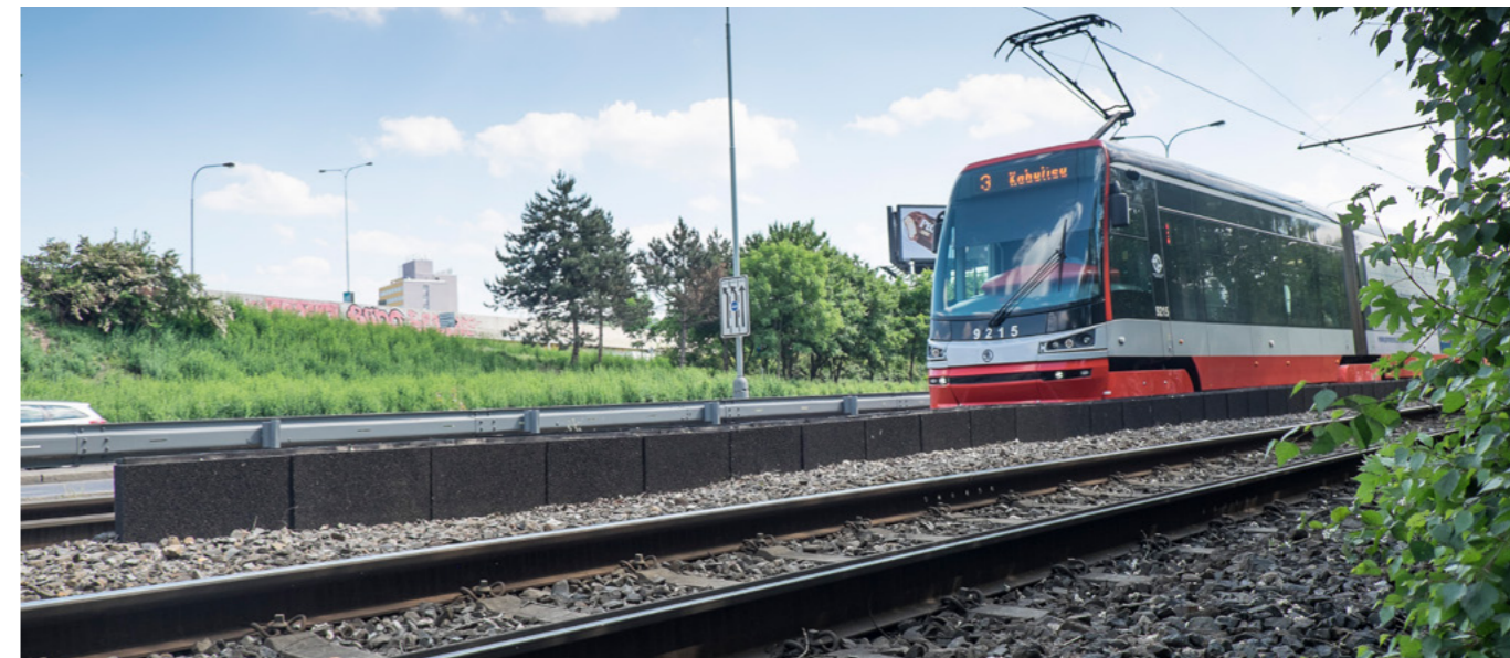
Mikrostěna dokáže splynout s okolím a je účinná i přes svou minimální výšku.
