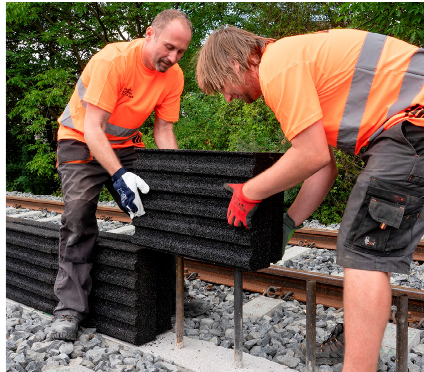
Mikrostěna je vyrobená z recyklátu.
